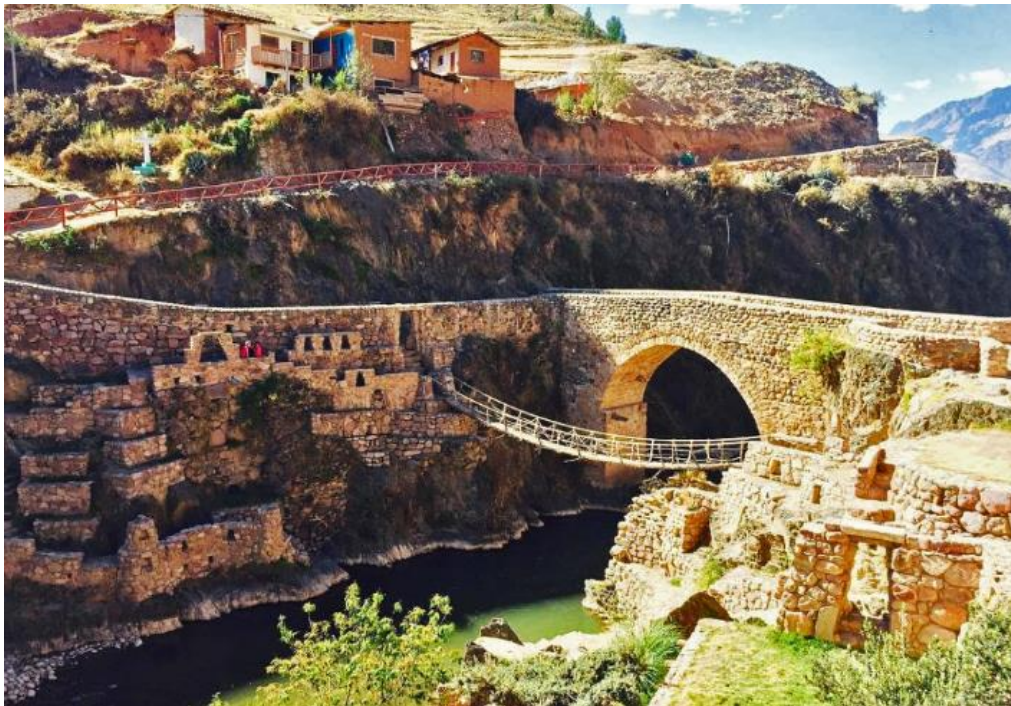
Fotografía: Puente Checaqupe
